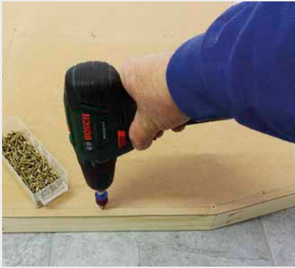
1. Bodenplatten anschrauben
