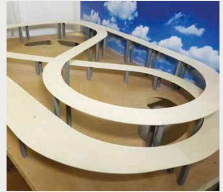
3. Die Gleistrasse ist fertig
